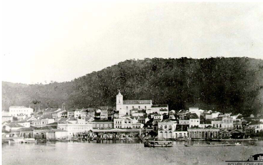
Foto 1 – A Cidade de Vitória e seu aspecto colonial, ainda presente em 1905. (Disponível em: < http://legado.vitoria.es.gov.br/baiadevitoria >. Acesso em: 18. Out. 2012)
